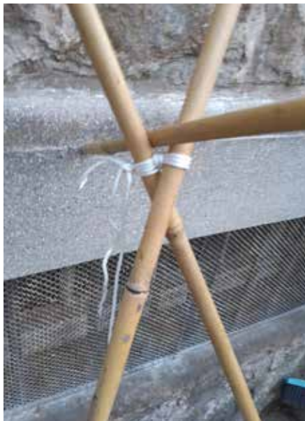
Auflegen und Verknoten der oberen Querstange
